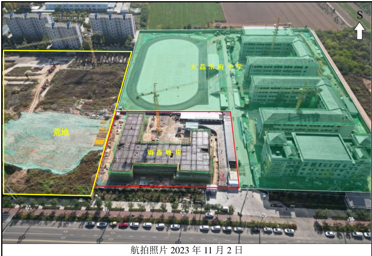
图 5-1 现场踏勘照片
