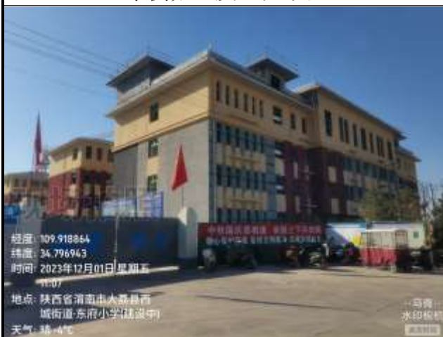
西侧大荔东府小学（在建）
